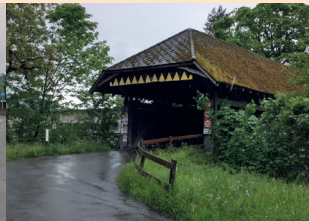
Über diese nasse Holzbrücke... Wooden bridge, it is slippery
